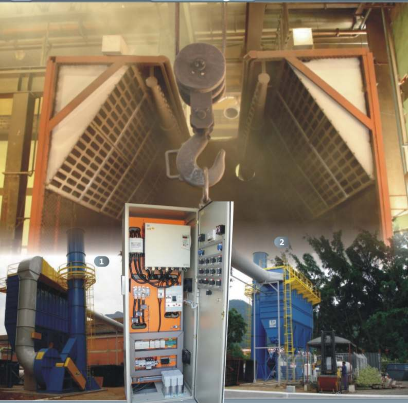
1 e 2 Sistema de aspiração e retenção em desmoldador de grande porte com automação e Soft Start WEG.
